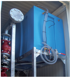
Serbatoio adescamento (in caso di installazione soprabattente) Storage tank in case of abovehead installation
