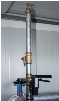
Kit splinker per protezione locale tecnico Sprinkler for protection of the technical roof
