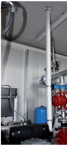
Condotto espulsione fumi Smokes outlet channel
