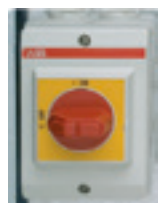
Interruttore marcia-arresto montato a bordo
